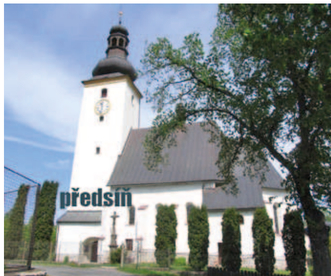
Kostel Věch svatých – předsín
