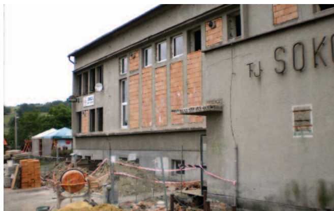
Červenec — práce na rekonstrukci začínají
