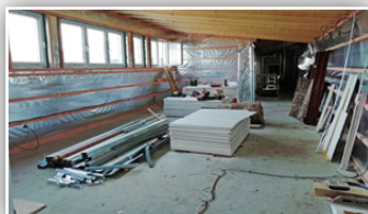
STAVBA SOCIÁLNÍHO ZÁZEMÍ NA HŘIŠTI
